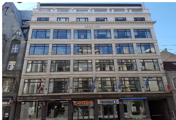
Biroju ēka «Open Centre» Brīvības ielā 39, Rīgā. Avots: Latio digitālais arhīvs
